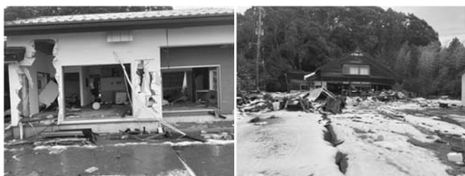
珠洲市の被害状況 第3次派遣隊撮影
