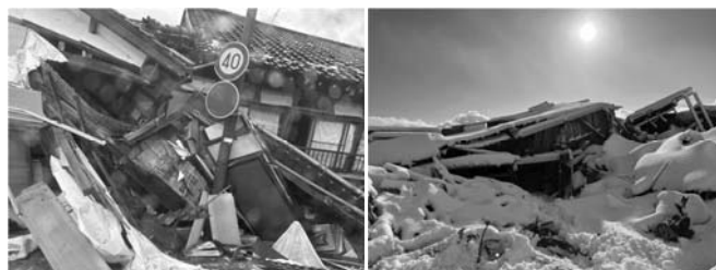
珠洲市の被害状況 第3次派遣隊撮影
