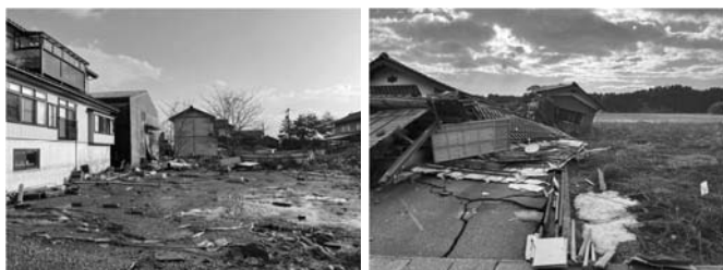
珠洲市の被害状況 第2次派遣隊撮影
